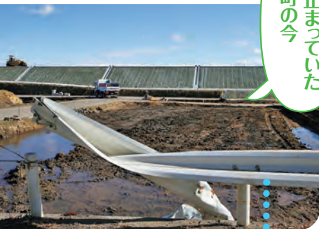
津波によりひしゃげたガードレール。浜街道が整備される以前は、向こうに海が見えていた
